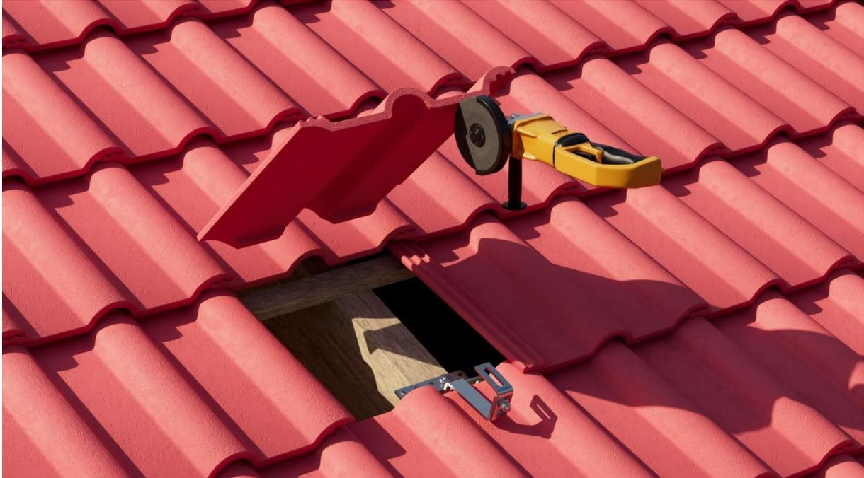
**⚠** Bitte beachten Sie bei der Bearbeitung von Dachziegeln die anerkannten Regeln des Dachdeckerhandwerks. Eine Bearbeitung von Dachziegeln führt regelmäßig zum Verlust der Gewährleistung und ggf. einer Garantie für die Dacheindeckung. Eine unsachgemäße Bearbeitung von Dachziegeln kann zur Undichtigkeit des Daches führen und erhebliche Schäden verursachen.
