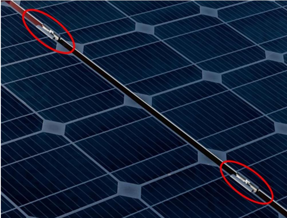
Halten Sie zwischen zwei Modulen einen Abstand von ca. 20mm. Dies ist die Klemmbreite der Modulklemmen.
